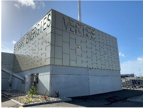
BLAGNAC ENERGIE VERTE Chaufferie Biomasse
