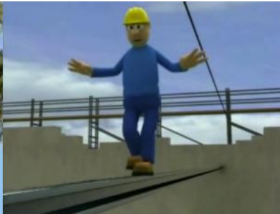
Travaux en hauteur sans protection collective
