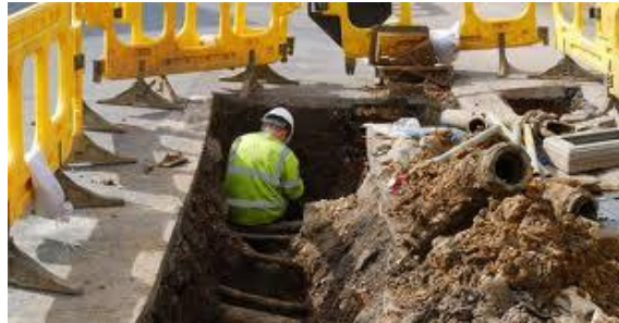
Travaux de tranchées, de démolition
